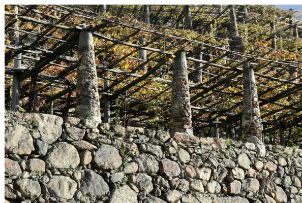
Le caratteristiche pergole sostenute da muri a secco e pilun
