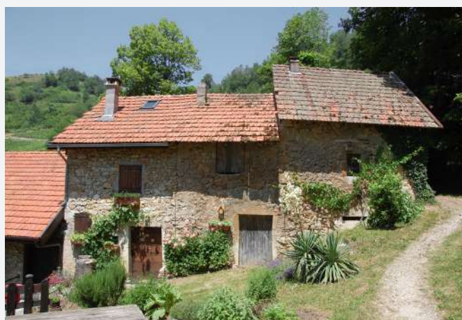
33 Bel ensemble de celliers restaurés, Saint-Jean-de-Chevelu (Savoie) | Bell'insieme di cantine ristrutturate, Saint-Jean-de-Chevelu (Savoie).
