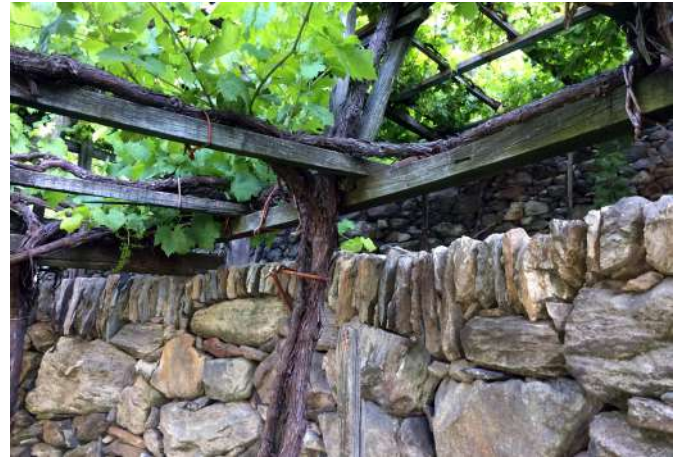
19 Mur en pierre sèche qui soutient une terrasse. Donnas (AO) | Muro in pietra a secco che sostiene un terrazzamento. Donnas (AO).
