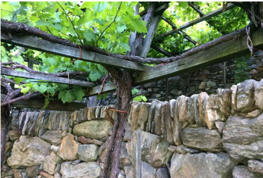
Figura 5. Pergola Valdostana alta: particolare dei muretti a secco e della struttura in legno.
