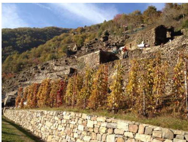
Fig. 5. Recupero dei terrazzamenti e del ciabòt a Pomaretto
