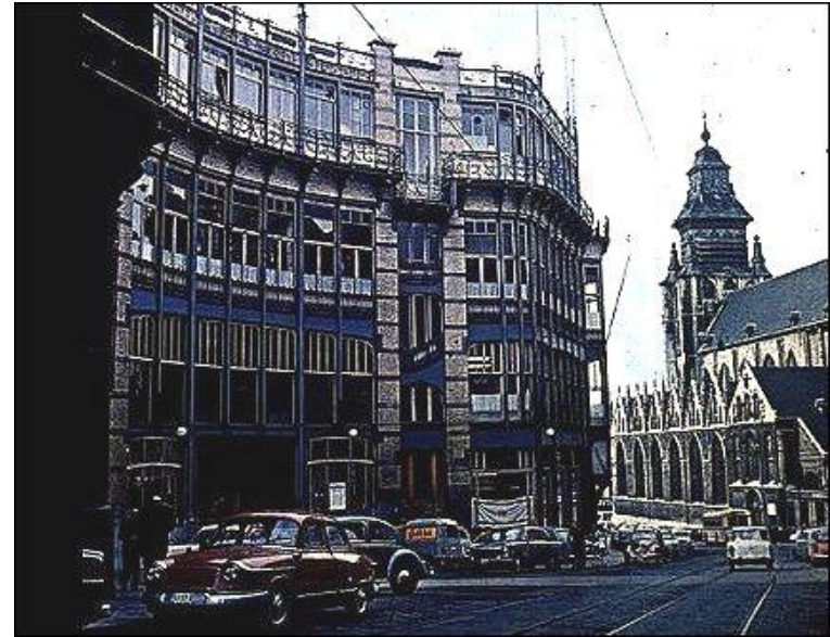
Casa del popolo, Bruxelles, 1895, Victor Horta, demolito nel 1965
