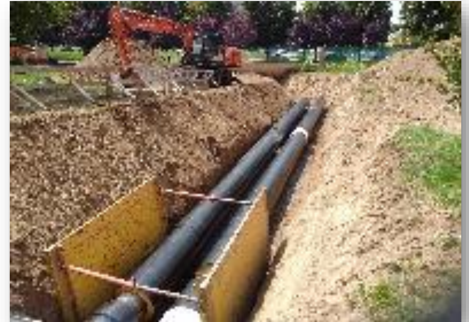
Posa rete collegamento TRM-Agraria
