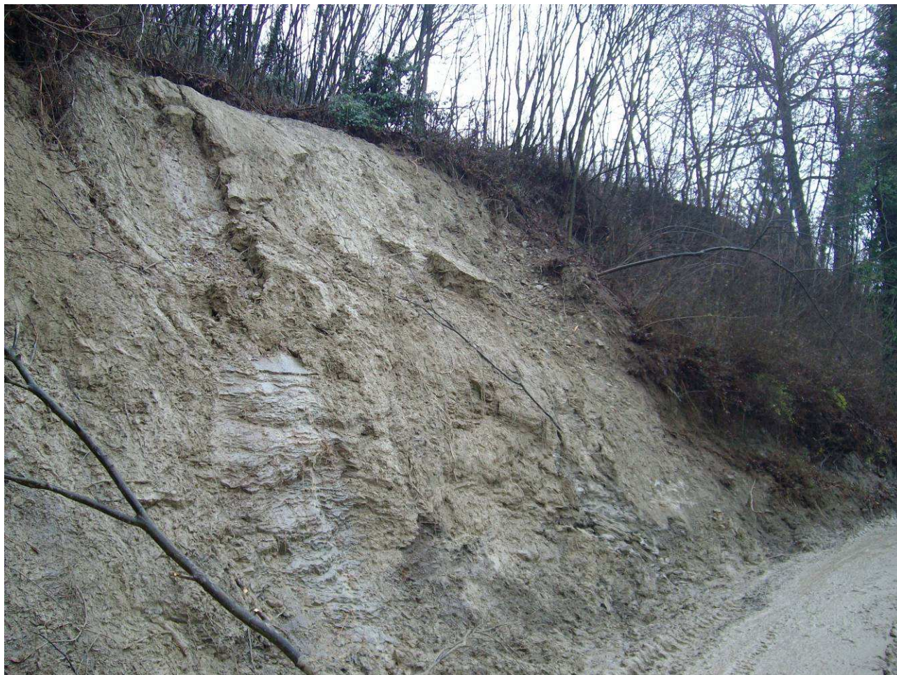
Vista della frana.
