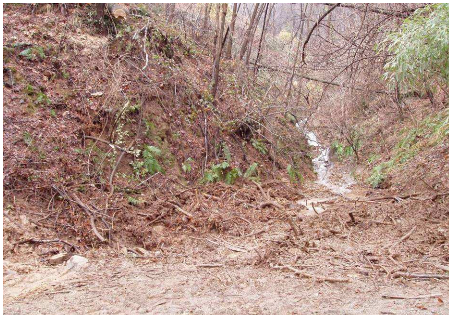
Vista del rio ostruito dai detriti vegetali a monte dell'attraversamento della strada del Lantaret Inf..
