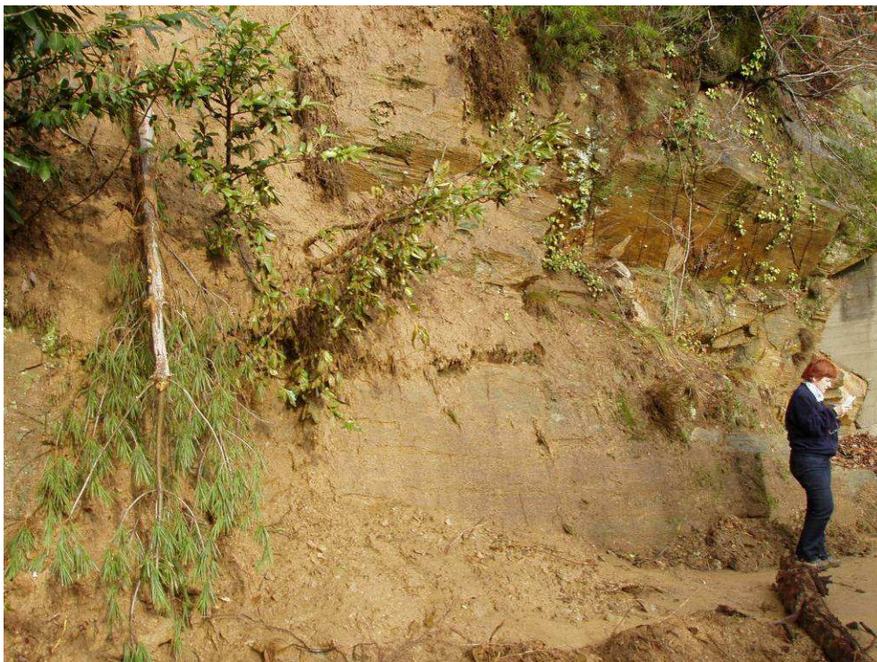
Il piede della parete ingombro del materiale di copertura fluidificato.
