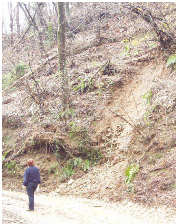
Vista del piccolo fenomeno di scivolamento lungo strada del Lantaret Inf. a circa 50 m dalla frana che ha bloccato la strada.
