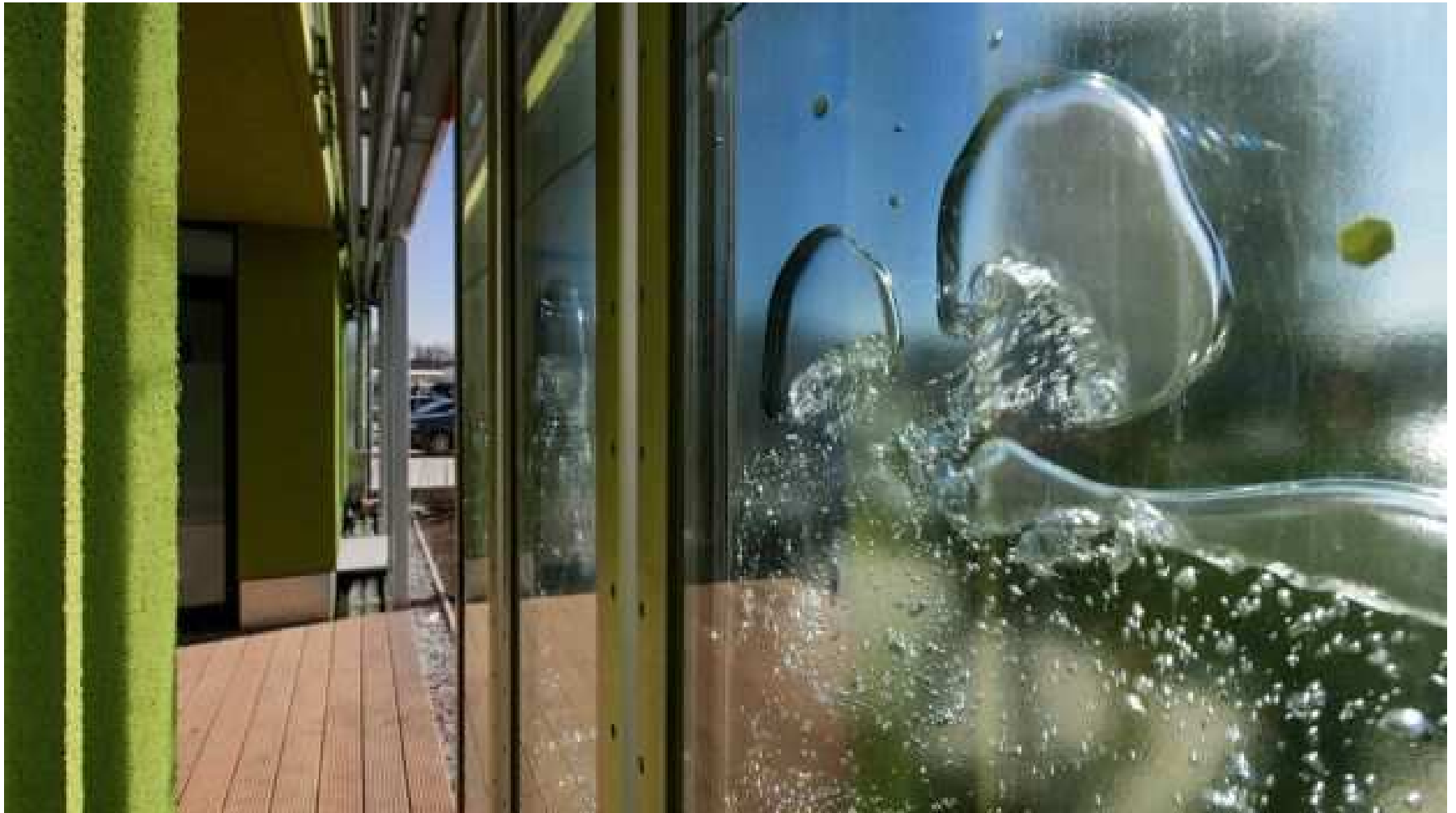
Biq House o Casa delle Alghe ad Amburgo, dettaglio facciata
