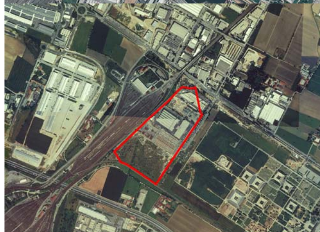
Foto aerea – Volto del 2003
