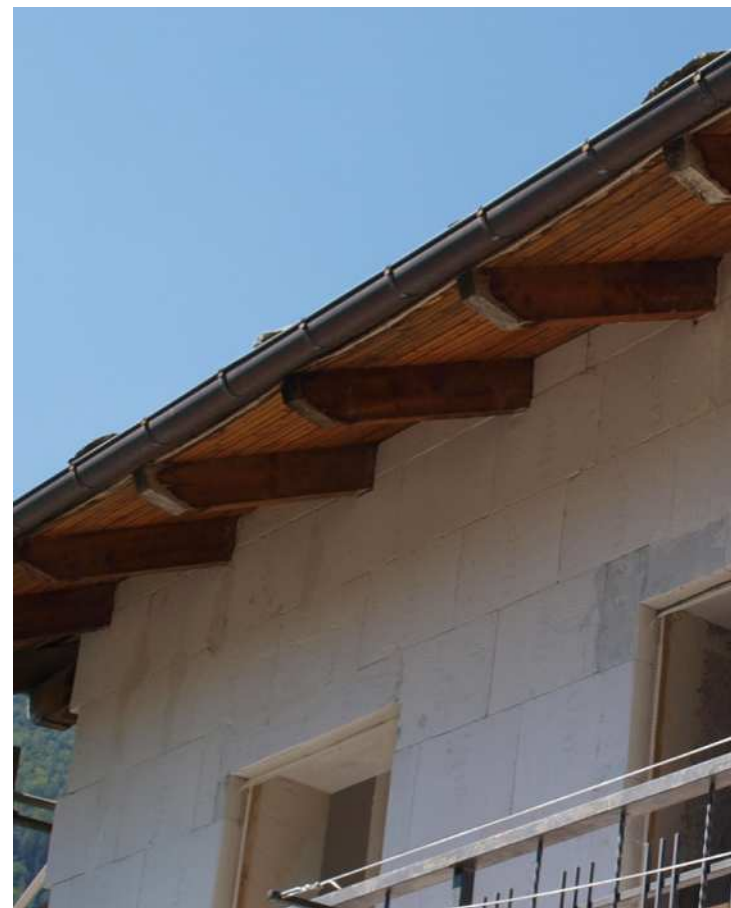
Realizzazione di cappotto termico su edificio
