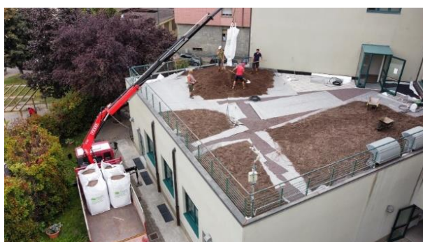
I lavori in corso a Torino
