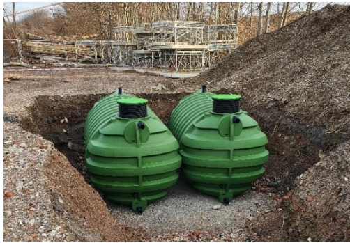
Serbatoi di plastica a Maribor
