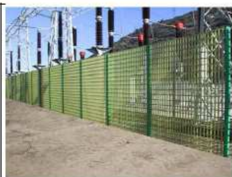
Recinzione i PRFV, materiale resistente e isolante, gravante su singoli plinti in cls interrati.
