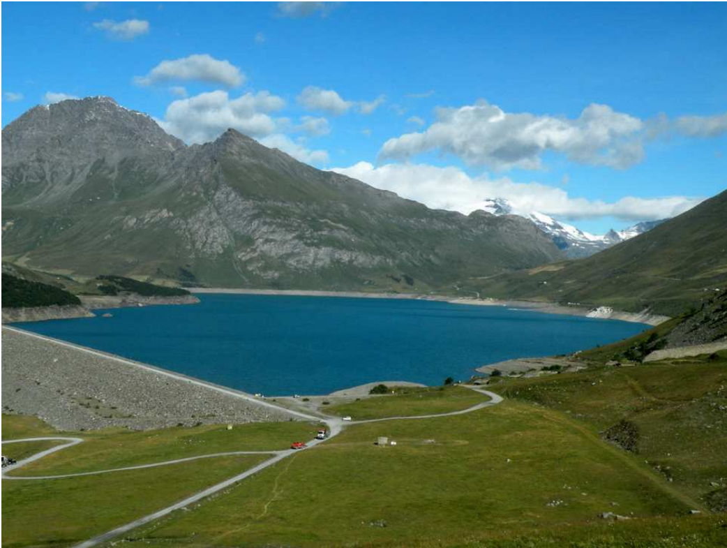
Figura 4.3 : lo sbarramento dell'invaso idroelettrico del Moncenisio.
