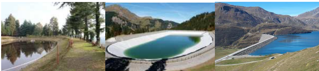
Esempi in Francia e in Italia di un piccolo sbarramento agricolo, uno sbarramento di montagna per la neve artificiale e uno sbarramento idroelettrico
