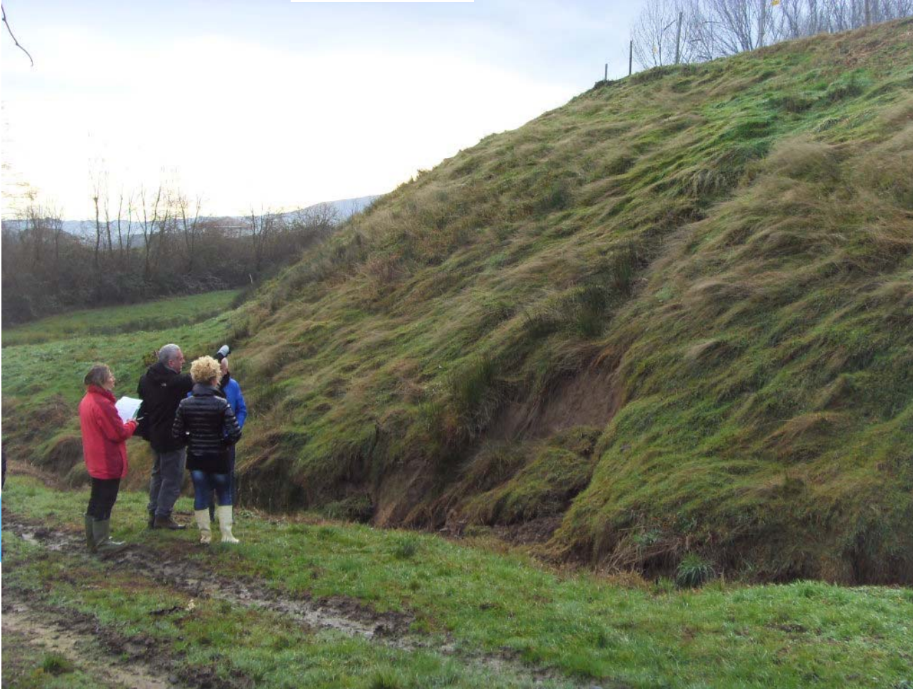
Sifonamento ed erosione interna
