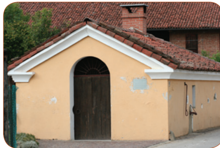
Forno a riscaldamento diretto, restaurato nel 2001
