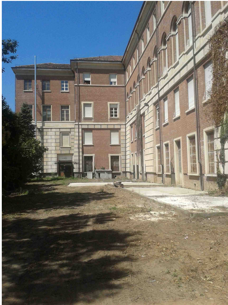
Facciata sud lato Darwin
