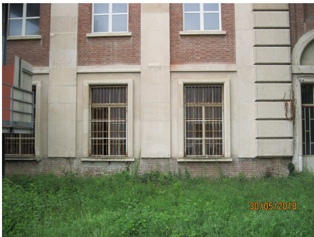
Serramenti da sostituire: medesimo disegno e dimensioni di quelli attuali. Materiale e colore analogo ai serramenti già presenti ai piani superiori.
