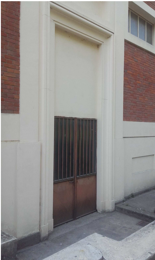
Il progetto prevede il ripristino dell'apertura originale con una vetrata e l'utilizzo della stessa come accesso esterno per la palestra.
