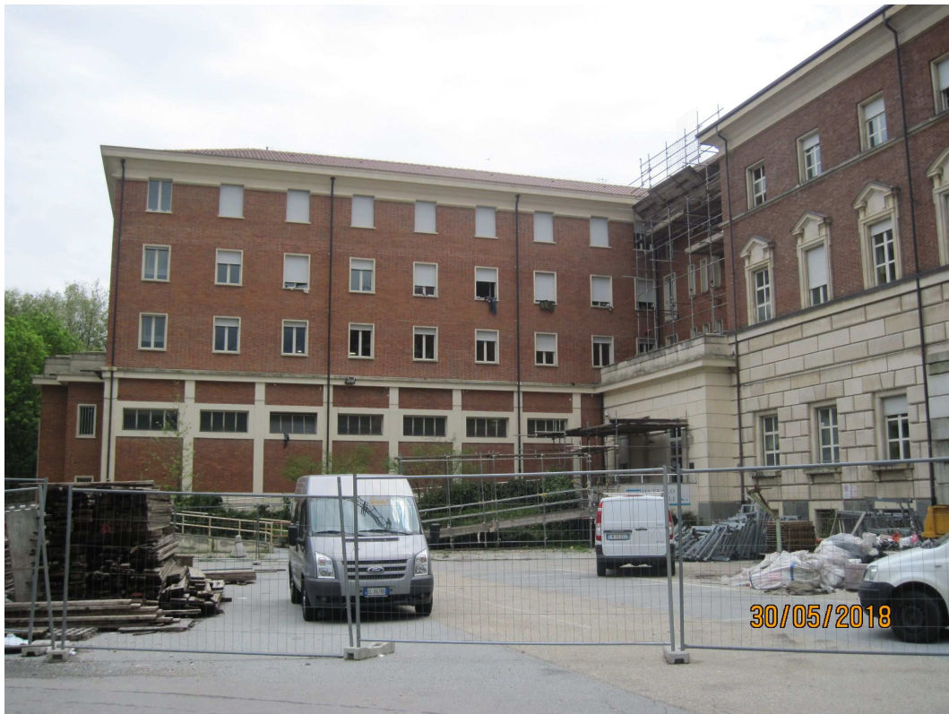
Innesto del corpo dell'Ostello sul fronte principale
