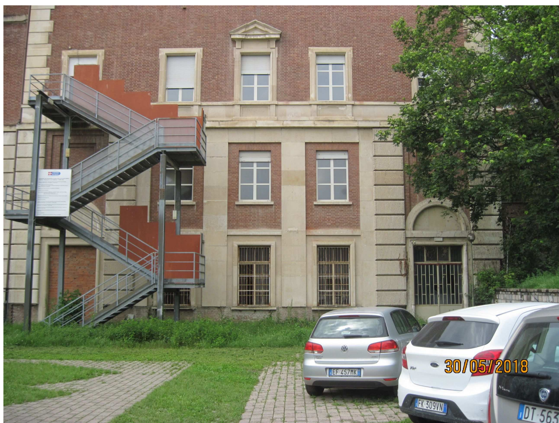
Fronte Est. Al piano basso le finestre della palestra
