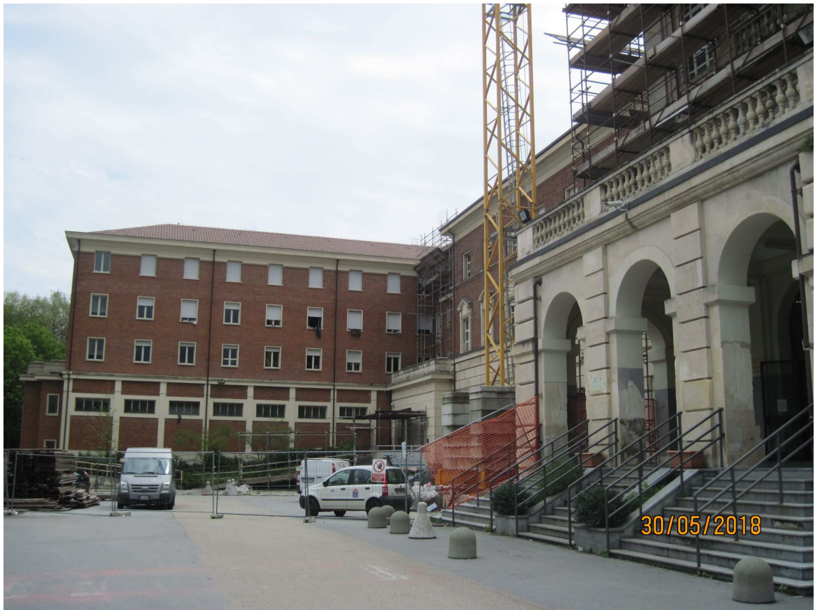
Facciata principale verso l'Ostello
