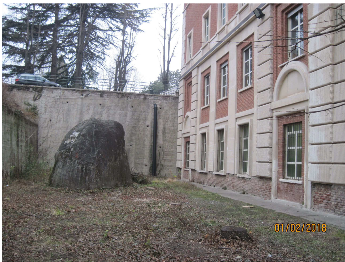
Prospetto laterale - serramenti già sostituiti
