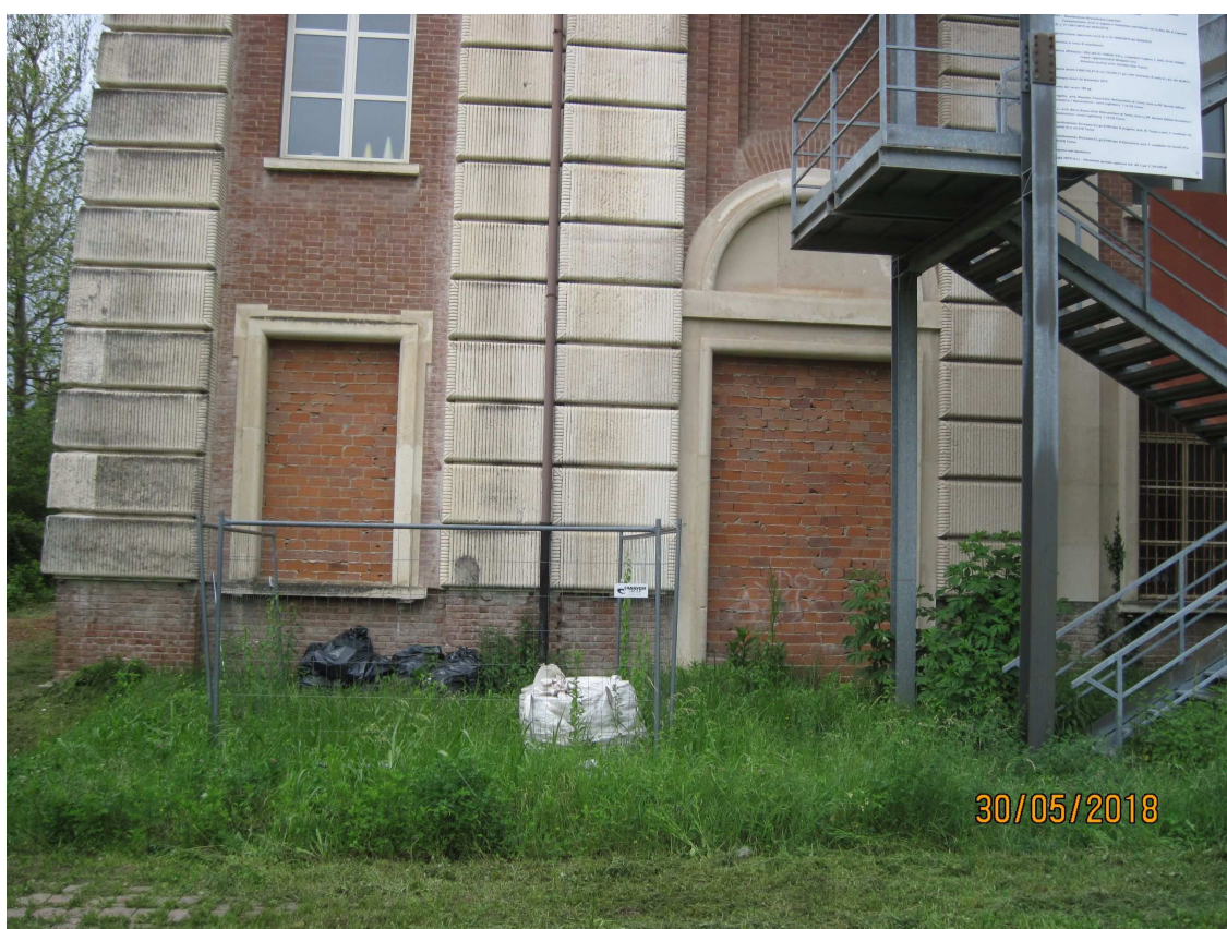
Ripristino aperture originali
