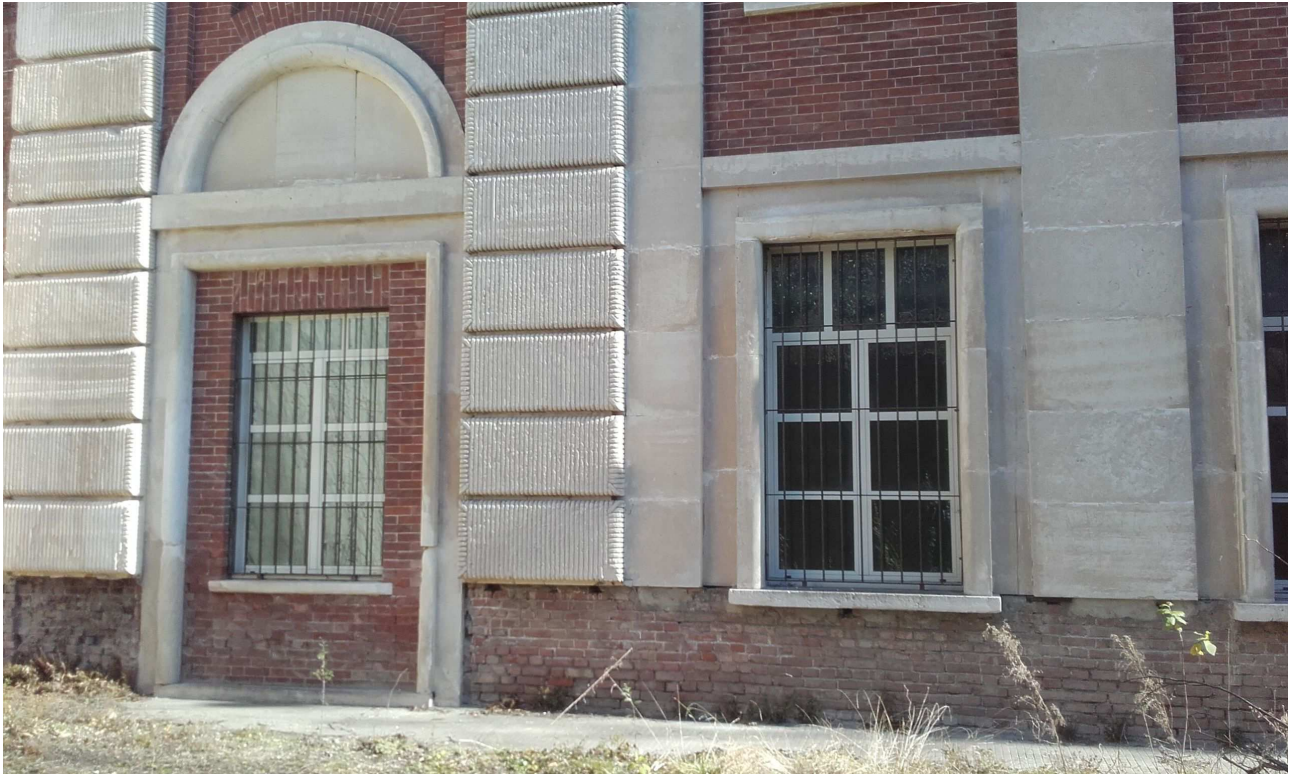
Serramenti palestra già sostituiti
