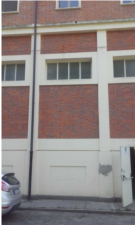
Particolare finestre palestra
