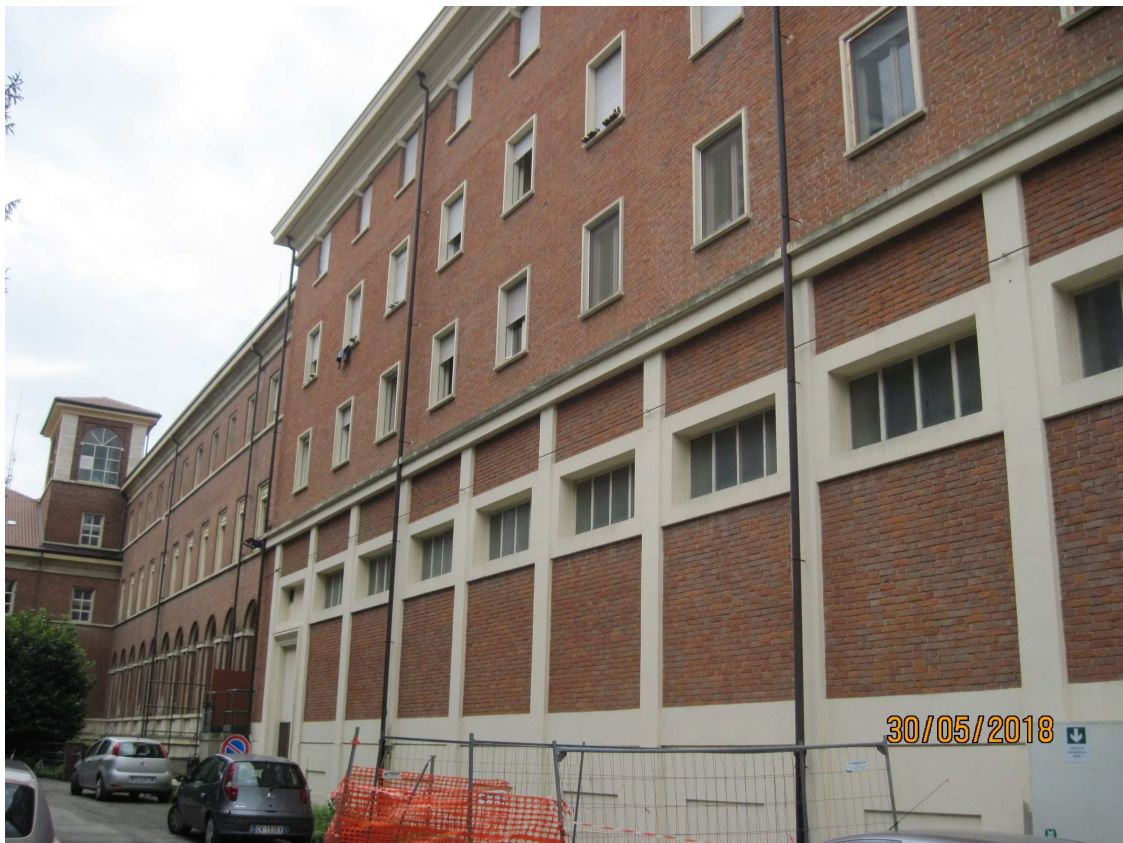
Facciata est corno Ostello
