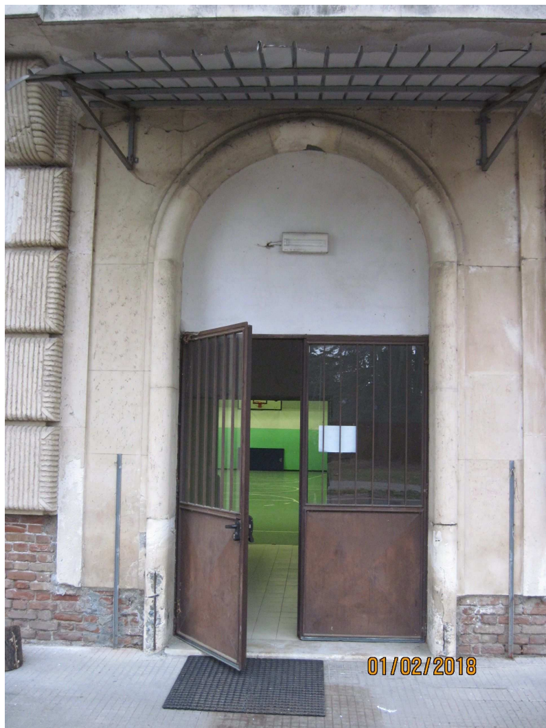
Ripristino apertura originale. Nuovo ingresso blocco palestre dall'esterno.
