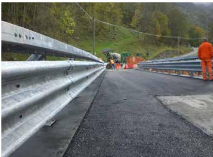
regolato da impianto semaforico o da movieri. I lavori consisteranno nell'allargamento della sede stradale per una sezione bitumata di circa m. 7.00-7.50, con posa di barriere stradali di protezione e opere di regimazione delle acque meteoriche con cunette alla francese; saranno anche ricostruiti i muri di sostegno di monte e di valle.
