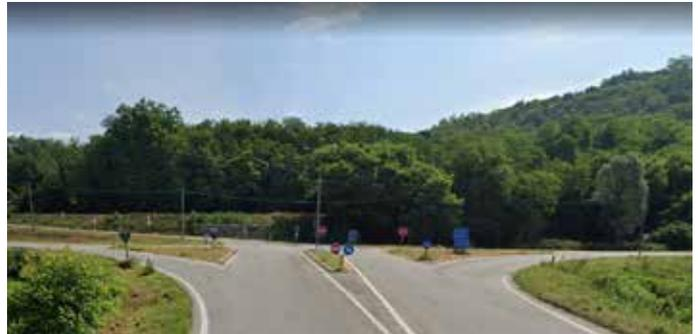
di 40 metri, con una larghezza di 3,5 metri per la corsia di entrata e di 4,5 metri per la corsia di uscita, e sarà illuminata da 15 pali periferici con proiettori a led. Il costo dell'opera si aggira sui 350mila euro.
